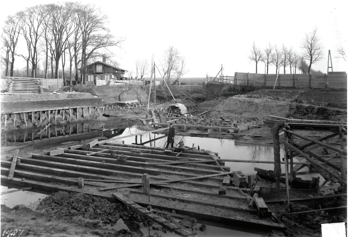
Figuur 23. De bouwkuip voor de Lammebrug, 1911 (ELO, GN006325).
