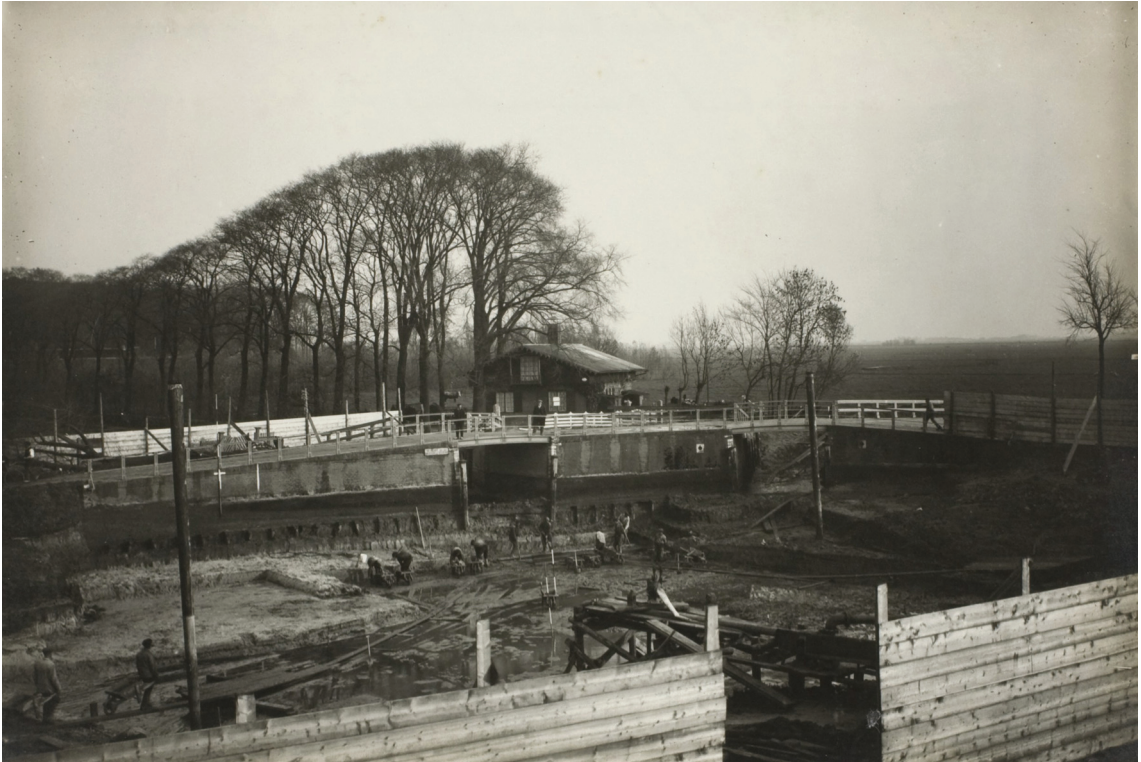
Figuur 22. Graafwerkzaamheden voor de Lammebrug in 1911, kijkend in zuidoostelijke richting (ELO, PV8468.10).
