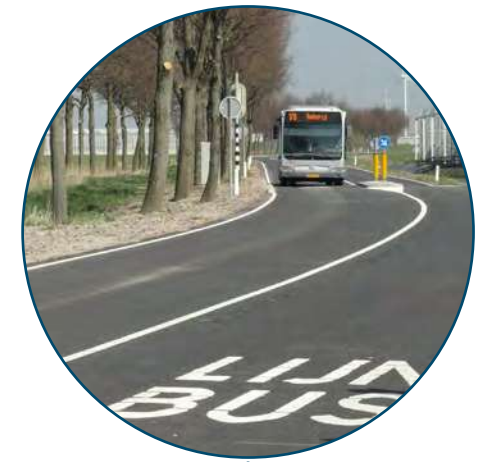
vrijliggende dubbele busbaan
